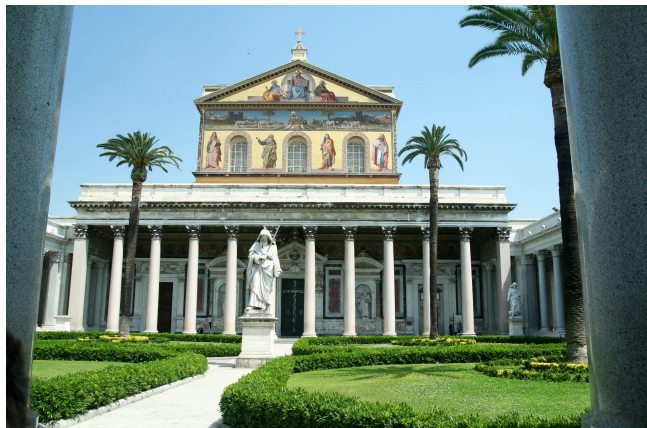
St. Paul vor den Mauern
